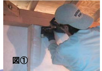
スタンダードロール耳付タイプ施工
