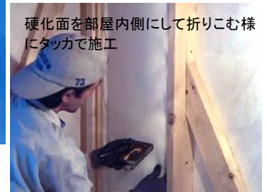
耳部分をにタツカで施工
