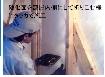
耳部分をにタツカで施工
